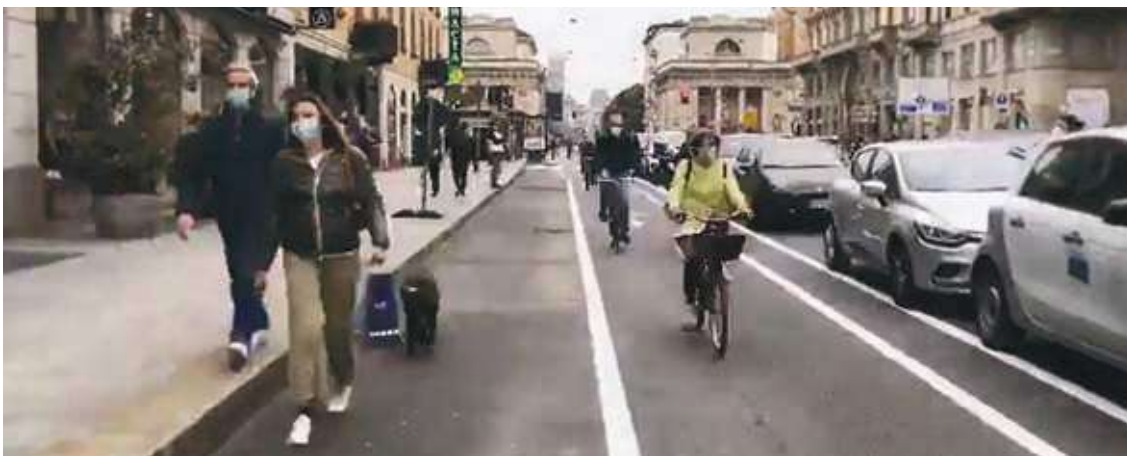
Figura 15. Ampliación de banquetas e instalación de ciclovía emergente en Corso Buenos Aires, Milán. (Foto: Demetrio Scopelliti)
